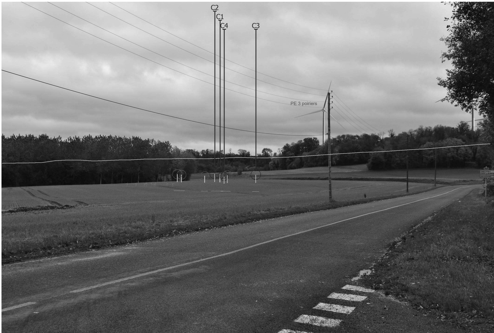
Parc éolien de Crouy et Cuffies
